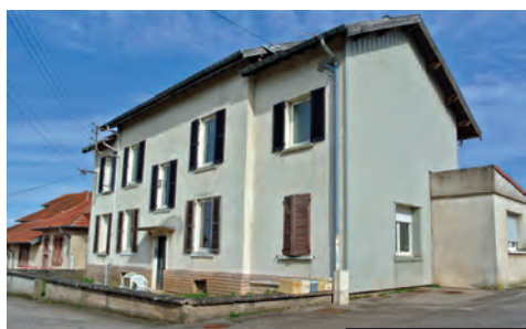
300 m 2 307 m 2 7 220 000 € Blainville Antonio 06 70 84 55 95 Immeuble de 4 appartements. DPE : en cours
